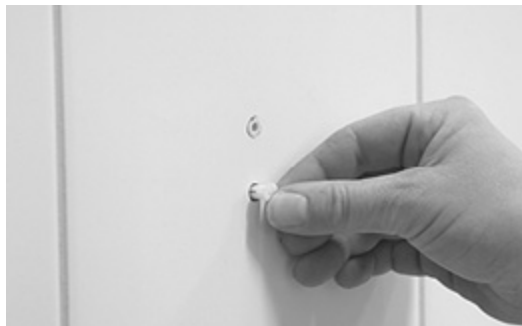
[ Bild 3.] Montera plastplugg avsedd för 5.5mm hål.
